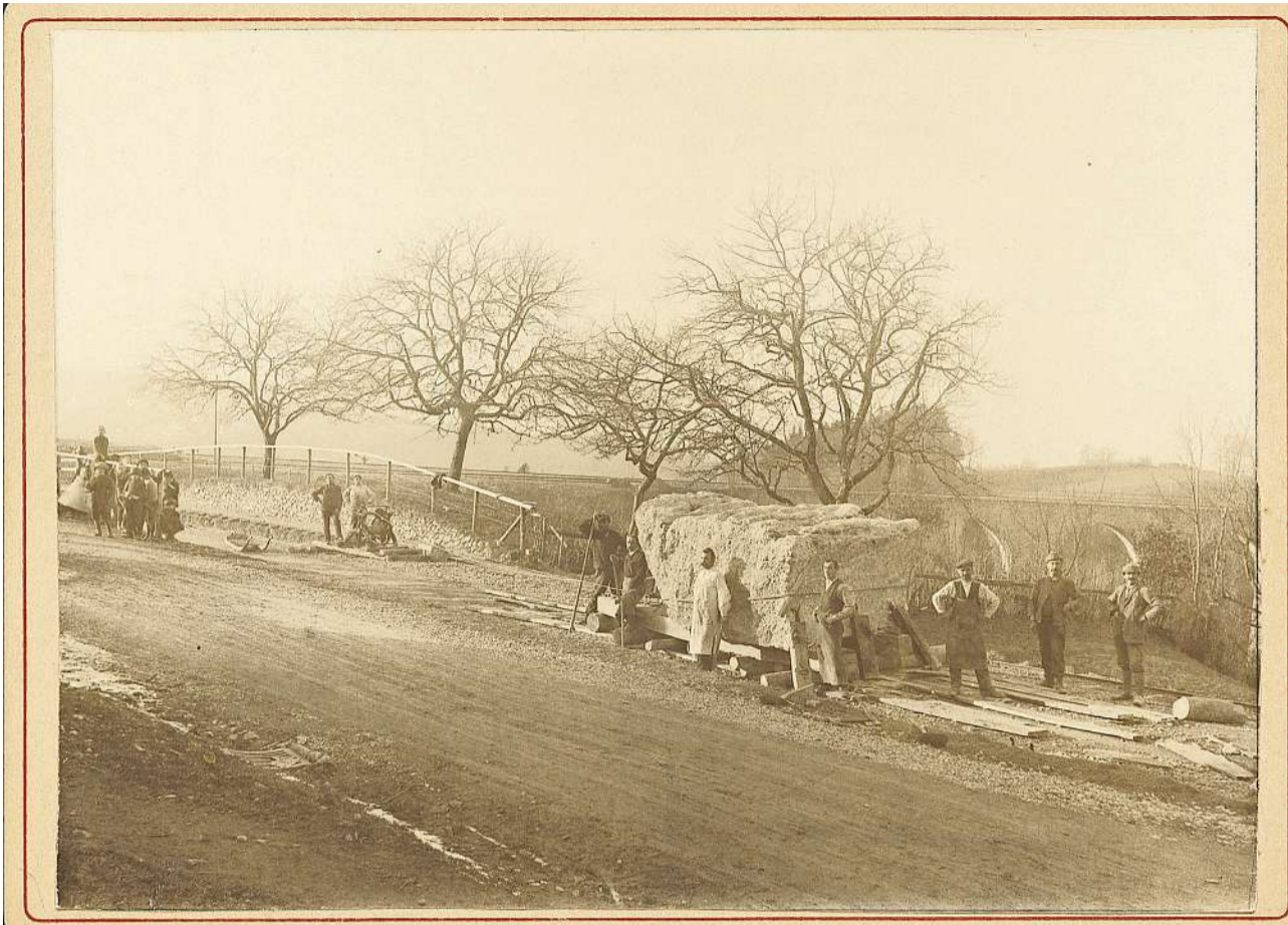
Riesiger Nagelfluhblock wurde aus dem Steinbruch Schachen nach Wattwil transportiert.
